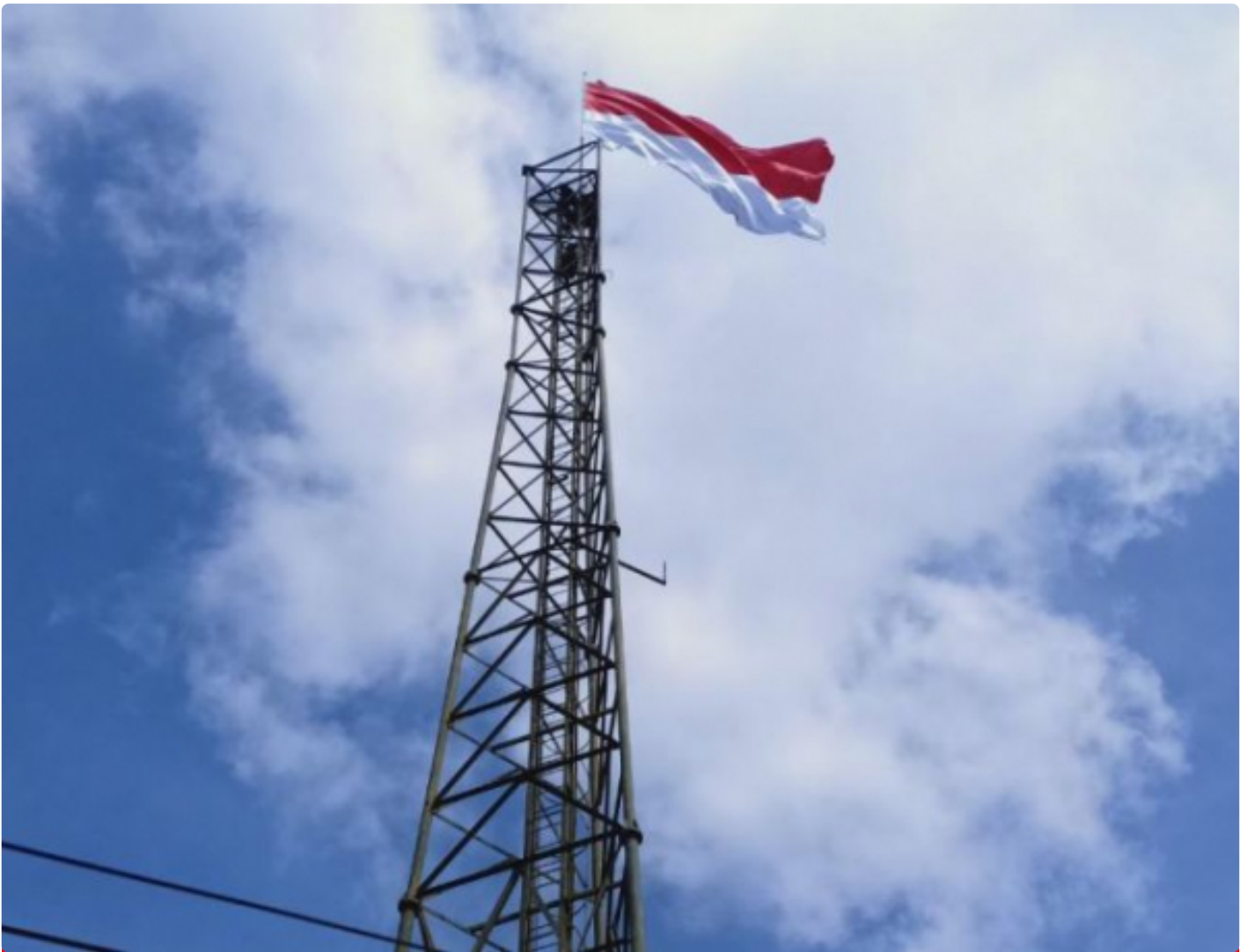
Danru Ariasa panjat menara 45 meter pasang Bendera Merah putih
